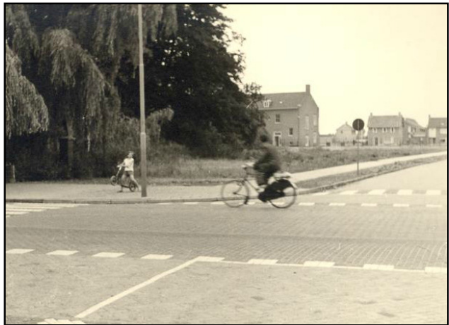
Na de sloop van de Koningshoeve werd ter plaatse de Boerhavestraat, later Kolonel Johnsonstraat, aangelegd. Op de achtergrond RK.basisschool Bernadette. Wijk Hoogeinde is in aanbouw op de oude landerijen van het oude leengoed Overaase Hoeve. (BHIC)
